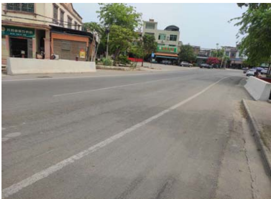
照片 1.1-1 桥梁正面照
