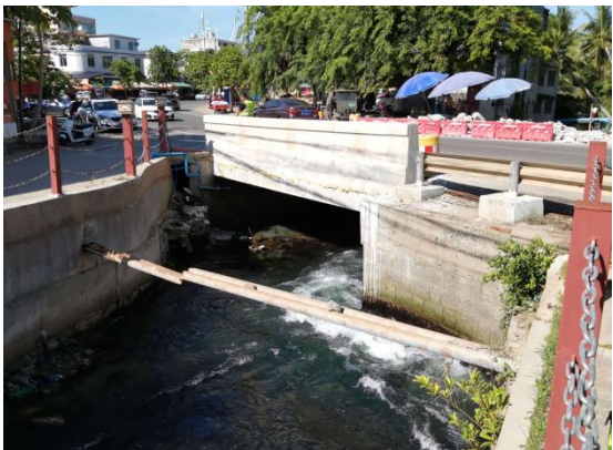
照片 1.1-2 桥梁右侧立面照
