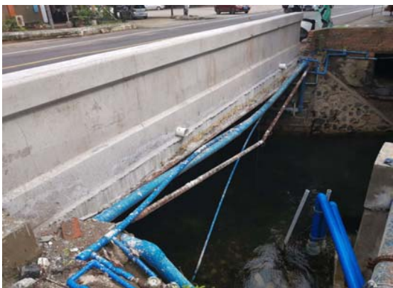
照片 1.1-3 桥梁左侧立面照
